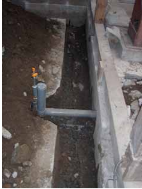
既存の土間コンをカッターで切り開いて、基礎の補強準備
